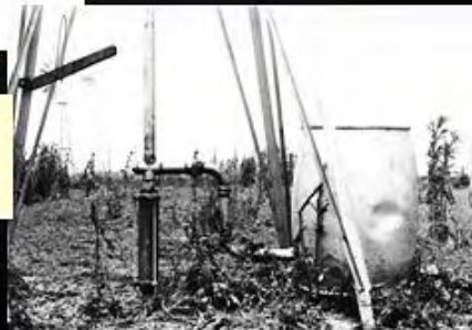
Extracción e impulsión simultánea de agua a altura por medio del molino
