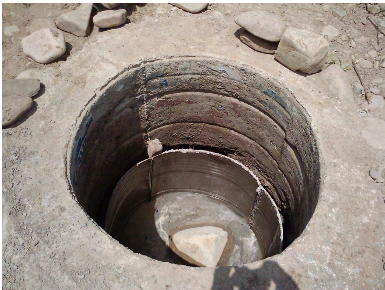
Figura 5.: Moldes colocados en el segundo tramo de excavación
