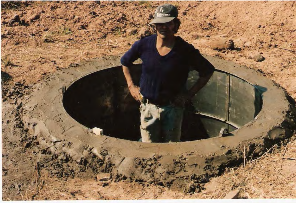
Figura 4.: Primera etapa de cementación, hormigón vaciado desde 0,9 m de profundidad hasta 10 cm sobre la superficie.
