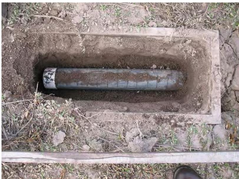
**Detalle de la zona de filtros para recarga inducida del acuífero, a la que luego se rellenó con grava tipo 1-2**
