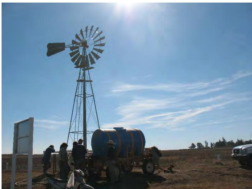
**Almacenamiento de 2.100 lts utilizado para efectuar la recarga artificial a las 4 perforaciones**
