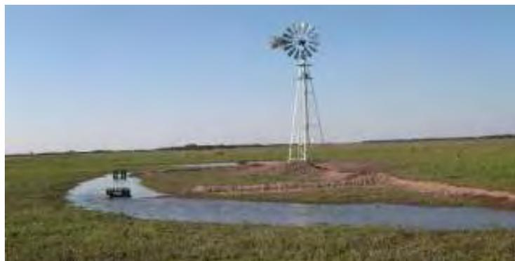
**Fig. 4-** Sistematización del sector de las perforaciones con un canal en forma de plato que permite inducir eficientemente el agua superficial de lluvia para recargar el acuífero.
