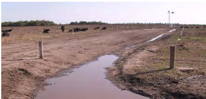
**Fig. 5- Sistematización del camino de acceso doble propósito: tránsito y cosecha de agua de lluvia, conduciéndola al sector de las perforaciones de manera eficiente.**
