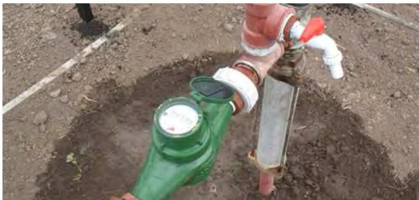
**Fig. 7- Caudalímetro implementado en el molino del Sistema A.**
