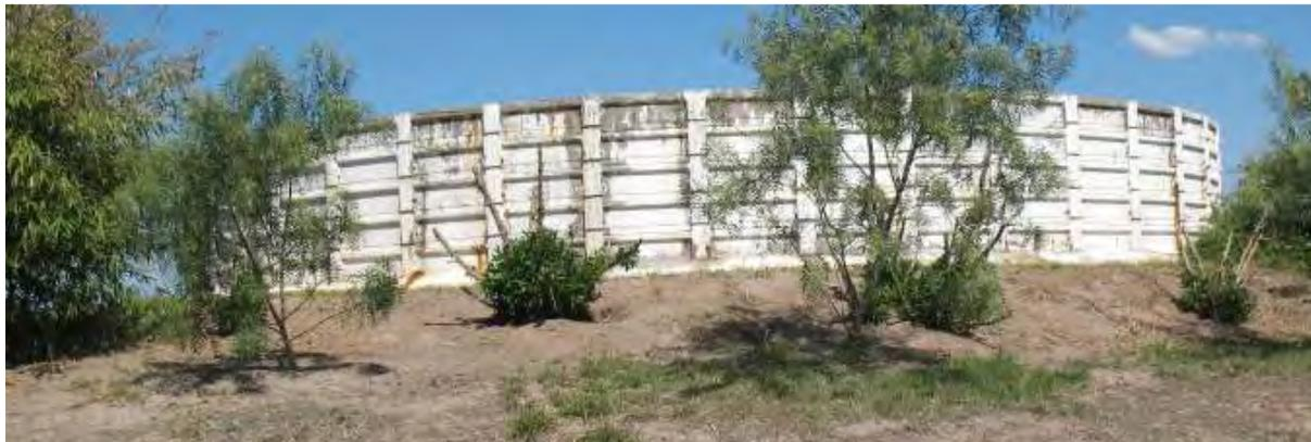
Fig. 12- Tanque central sobreelevado de mezcla de los 3 sistemas A, B y C, con reserva para 15 días.
