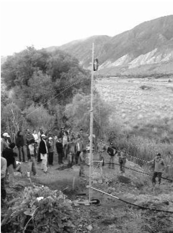
Foto 2. Participantes del Proceso de Formación realizando prácticas con bomba de soga y bomba jira en el parque hídrico de Hornillos
