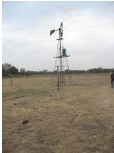
Molino con sistema patas de araña compuesto por 2 perforaciones en bajo natural del paleocauce.
