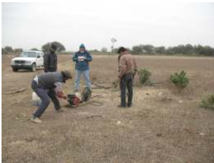
Perforación con sistema de bombeo a combustión con inferior calidad de agua (agua con exceso de sales). Al fondo se puede visualizar el molino con el sistema patas de araña.
