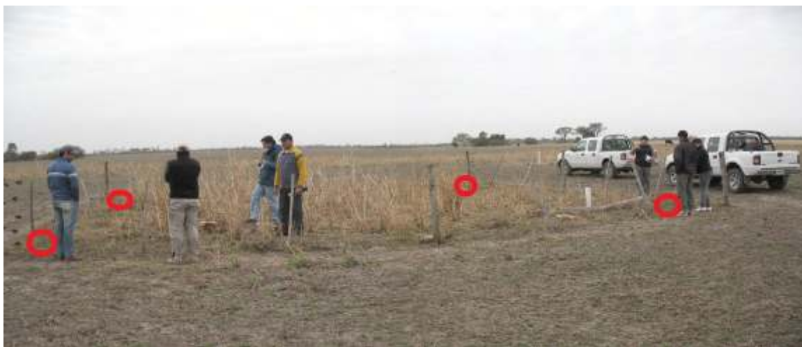
Ubicación de las potenciales perforaciones para conformar un sistema patas de araña con el molino exactamente en el medio de ese sector cercado, con un antepozo de 3 m de profundidad.
