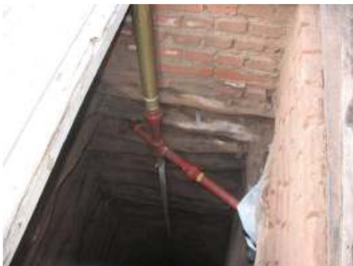
**Detalle de la bomba del molino y de las cañerías de succión.**
