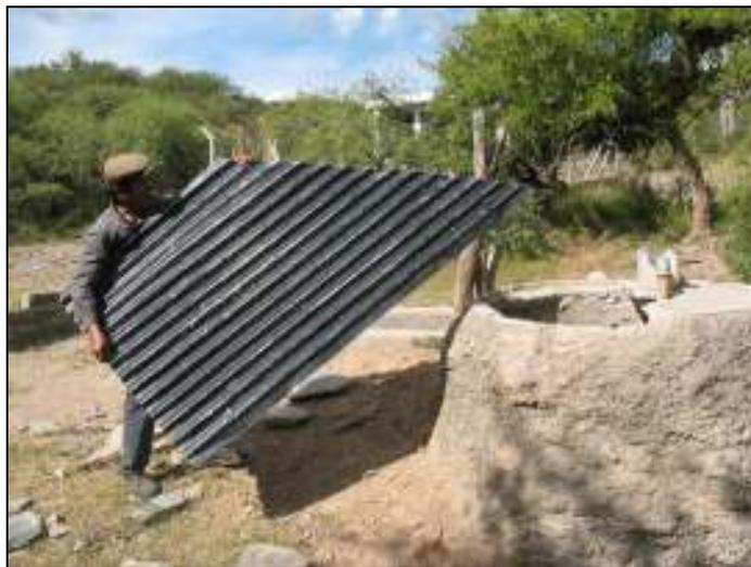
**Manuel cuidadosamente vuelve a tapar el pozo con una chapa, porque la tapa original se ha roto. Es deseable ser reconstruya la tapa con un material duradero.**
