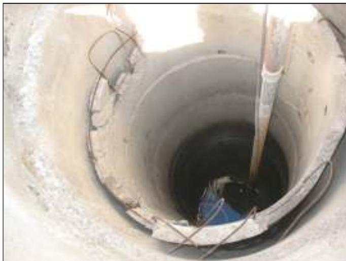
**Pozo comunitario calzado con anillos premoldeados y electrobomba sumergible**
