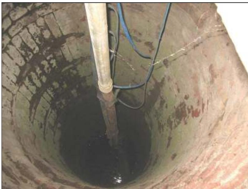
**Pozo calzado de 7 m de prof. con electrobomba sumergible. Primera fuente del tambo.**
