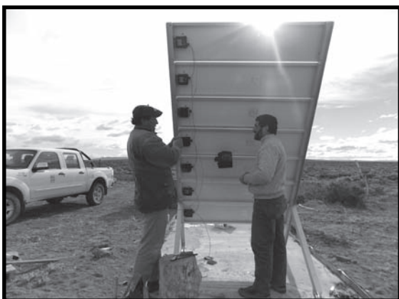
■ Foto 2: Bombeo solar en Paso Aguerre. Armado y conexión de paneles solares
