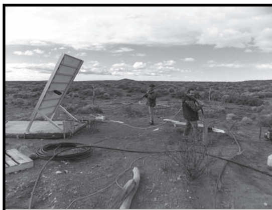
■ Foto 3: Bombeo solar en Paso Aguerre. Instalación de bomba
