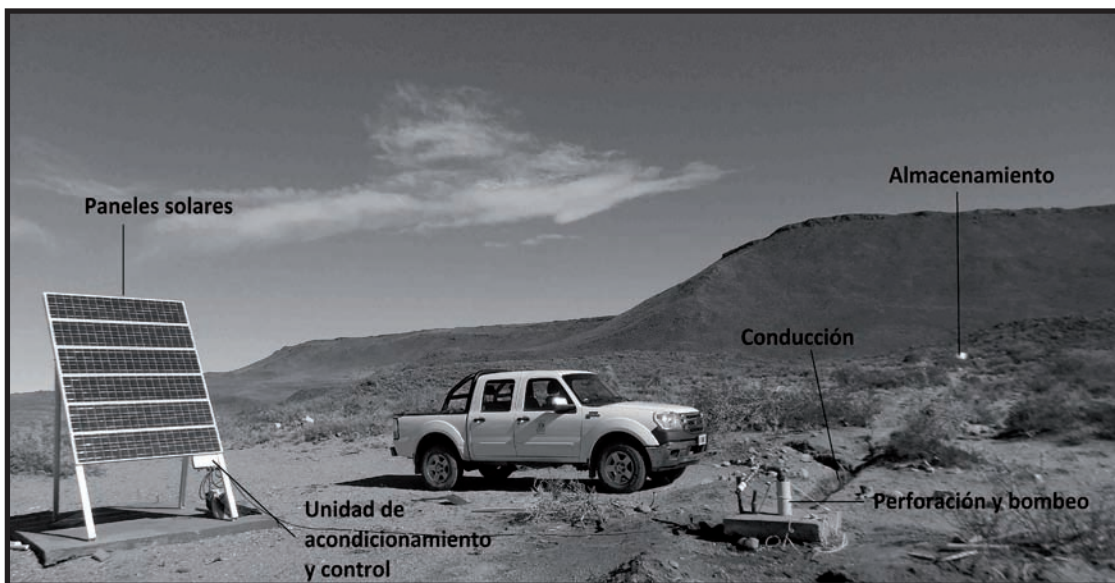
■ Foto 1: Bombeo en la comunidad mapuche Calfucura. Se visualizan los distintos componentes del sistema
