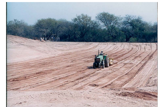
Construcción de una represa con tractor y pala de arrastre. masaqui- naria ideal para este tipo de obra.
