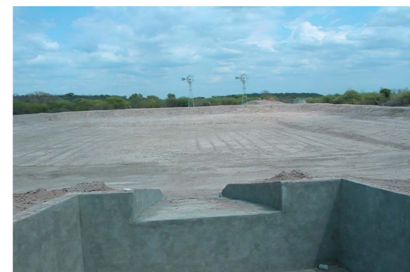
Trampa de sedimentos previa al ingreso del agua del área de captación al reservorio permite alargar la vida útil de dicha obra.
