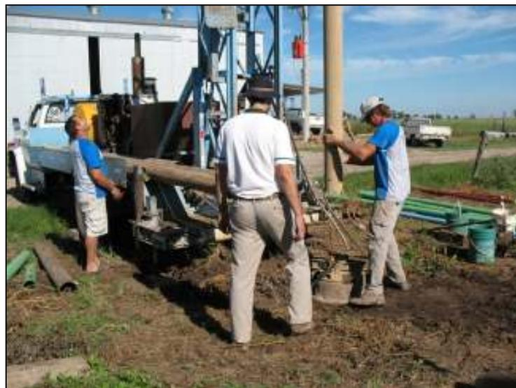
**Método por percusión en el sector de arenas a partir de los 16,5 m de profundidad.**
