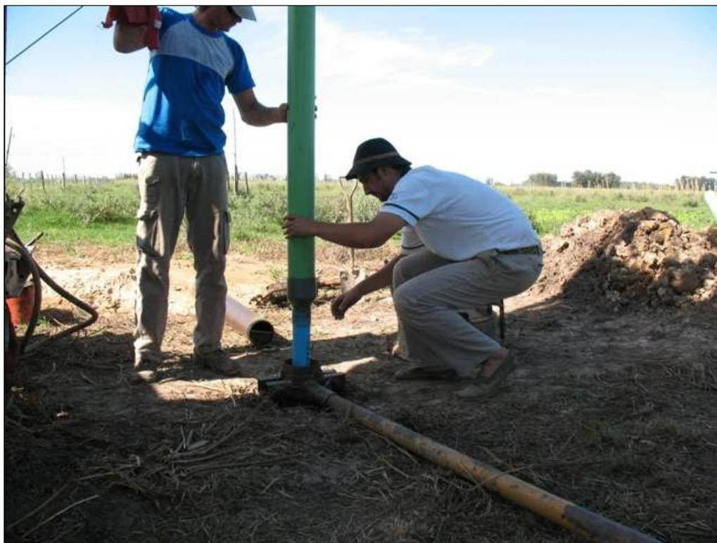
**Comienzo de la colocación del filtro en la perforación. Se observa el buje reducción de 115 a 75 mm que permite la unión del filtro con el encamisado superior.**
