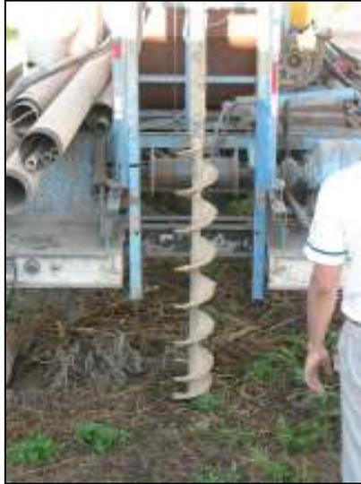
**Sistema rotativo para los primeros metros sin utilización de lodo de inyección ( $\phi = 200$  mm).**
