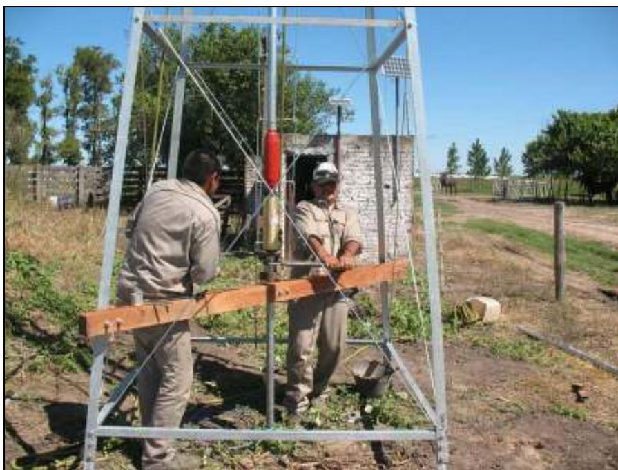
**Momento de la instalación de la cañería que sostiene a la electrobomba sumergible con la bomba del molino.**
