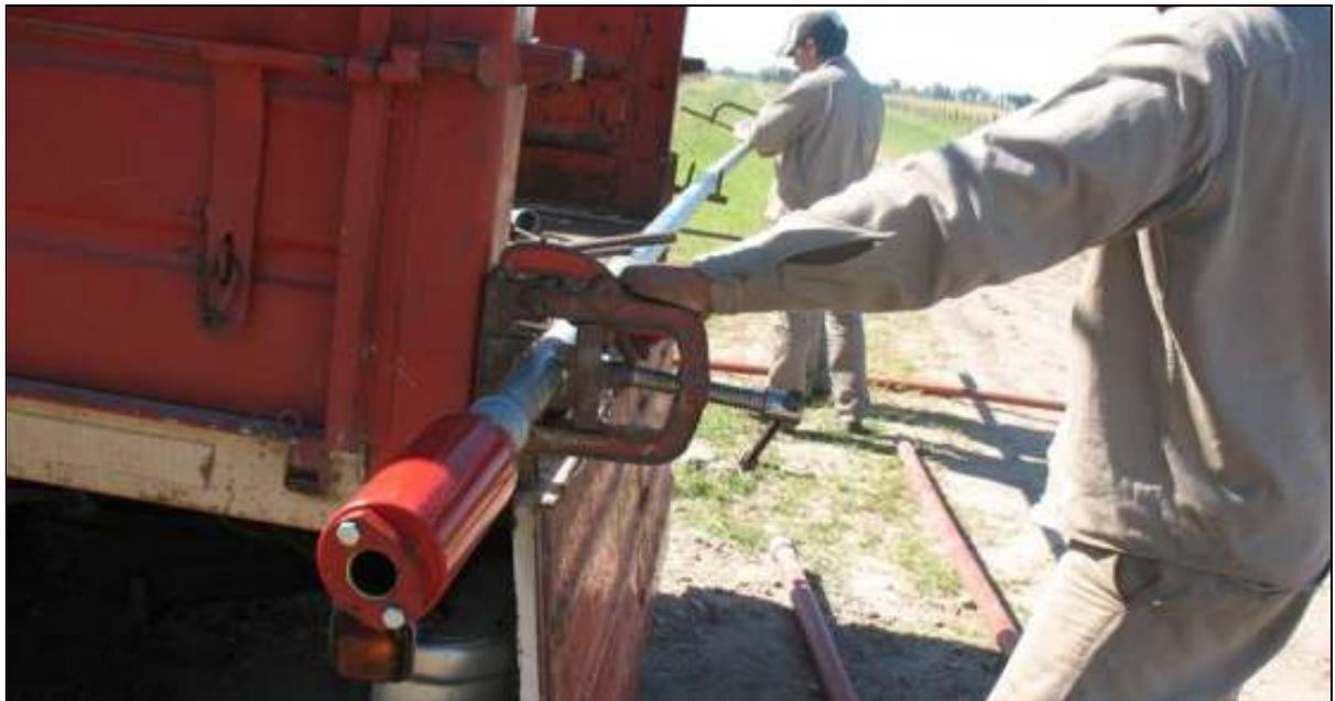
**Colocación de un elevador de agua en la parte superior de la cañería del molino.**
