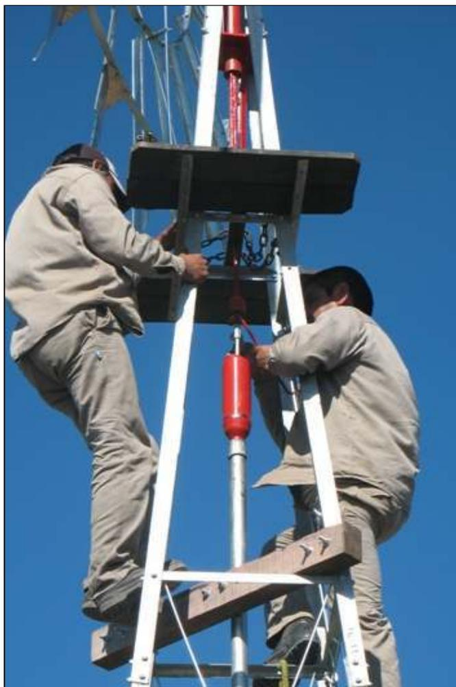
**Elevador de agua instalado en la parte superior de la cañería del molino.**
