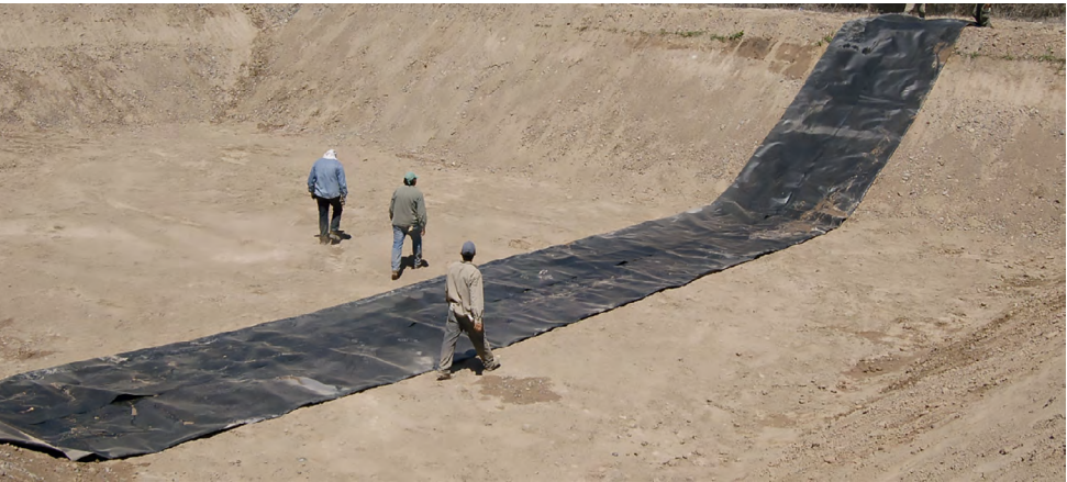
Inicio de los trabajos de impermeabilización con geomembranas, en una represa del departamento Pocito
