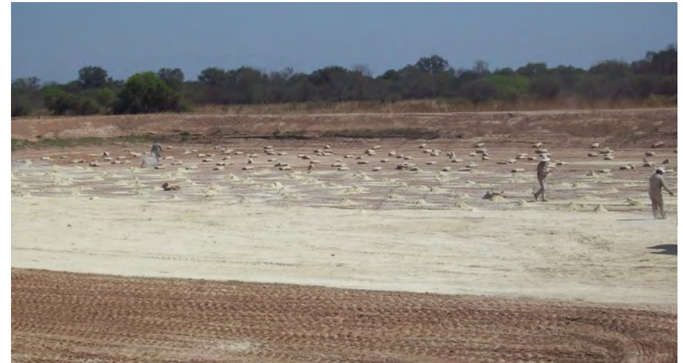
Personal distribuyendo bentonita de manera manual en una represa en el norte del País.
