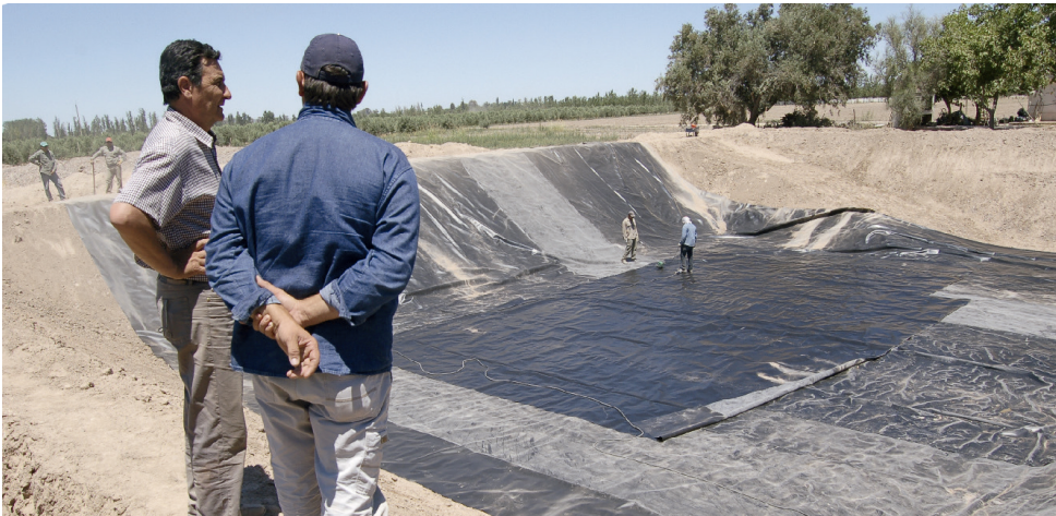
Importante grado de avance en el proceso de impermeabilización de la misma represa mostrada en la foto anterior.
