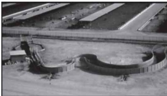
Fig. 7. *Vista aérea de un corral curvo que conduce a un bañadero. Es el mismo diseño básico de la figura 6. Se pueden bañar 600 animales por hora en este sistema (www.grandin.com).*
