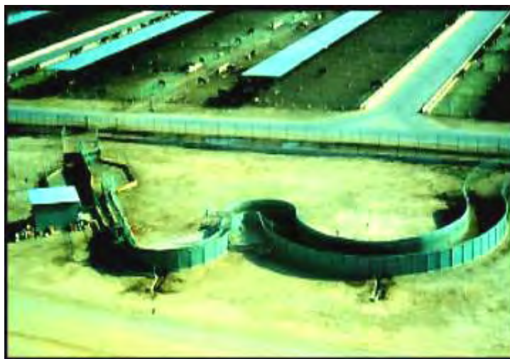
Fig. 7. Vista aérea de un corral curvo que conduce a un bañadero. Es el mismo diseño básico de la figura 6. Se pueden bañar 600 animales por hora en este sistema.
