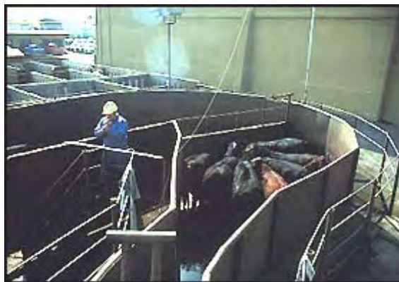
Fig. 2. Corral de encierro circular con paredes cerradas y puerta giratoria sólida. Una persona puede operar la puerta desde afuera del corral. Se deben instalar pequeñas puertas de escape para los trabajadores. El corral de encierro debe terminar en un embudo a la entrada de la manga, con una pared recta y la otra en ángulo de 30°. Los animales tenderán a atascarse si ambos lados están en ángulo respecto de las paredes de la manga.
