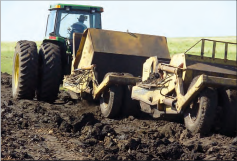
Foto 3. Construcción de terraplén
