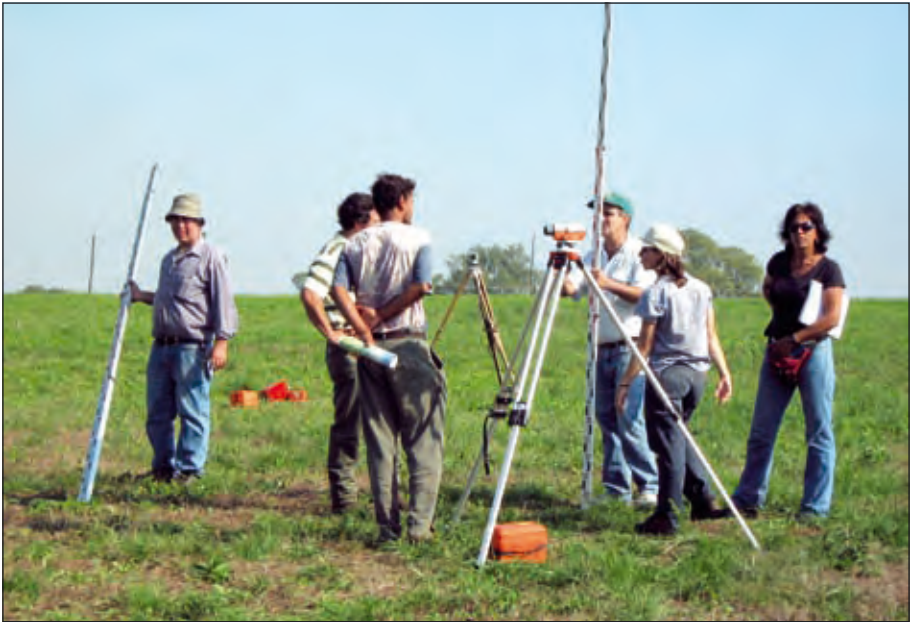
Foto 2. Marcación de la obra
