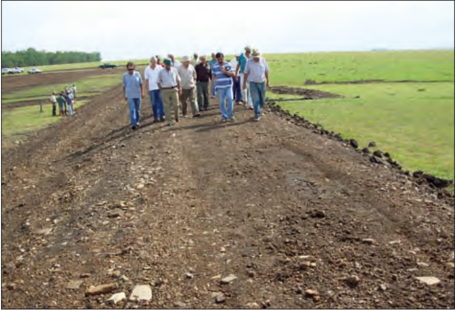
Foto 1. Inspección en Paraje Topador, Artigas
