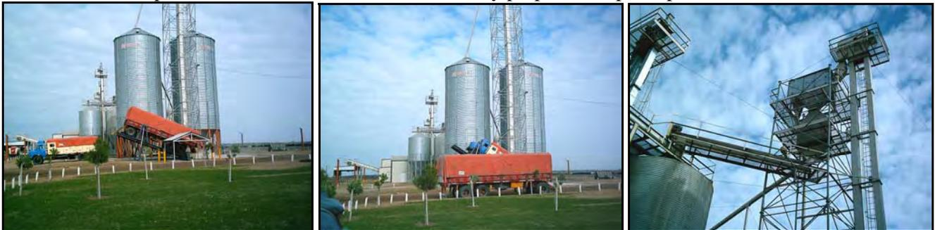
a y b)-Descarga de acoplado y chasis con granos y pellets; c)-Sistema de norias de distribución.
