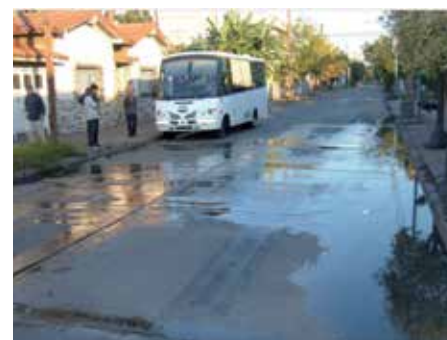
Calle anegada por resquebrajamiento del asfalto debido a ascenso de napas. Lanús. Fotografía tomada por Ana Carolina Herrero. 2009.
