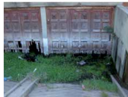
Sótano inundado debido al ascenso de napas. Lanús. Fotografía tomada por Ana Carolina Herrero. 2009.
