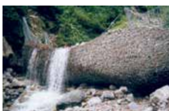
Figura 3. Pequeñas retenciones del escurrimiento: a) de postes impregnados y bolsas de tierra; b) barreras flexibles permeables, con redes de anillo. (Fuente: Geobruigg, 2012).
