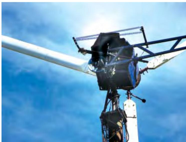
La idea de los molinos con transmisión oleohidráulica es que permiten obtener un elevado rendimiento de la energía generada en el molino y una gran diversidad de usos por medio de motores hidráulicos.
