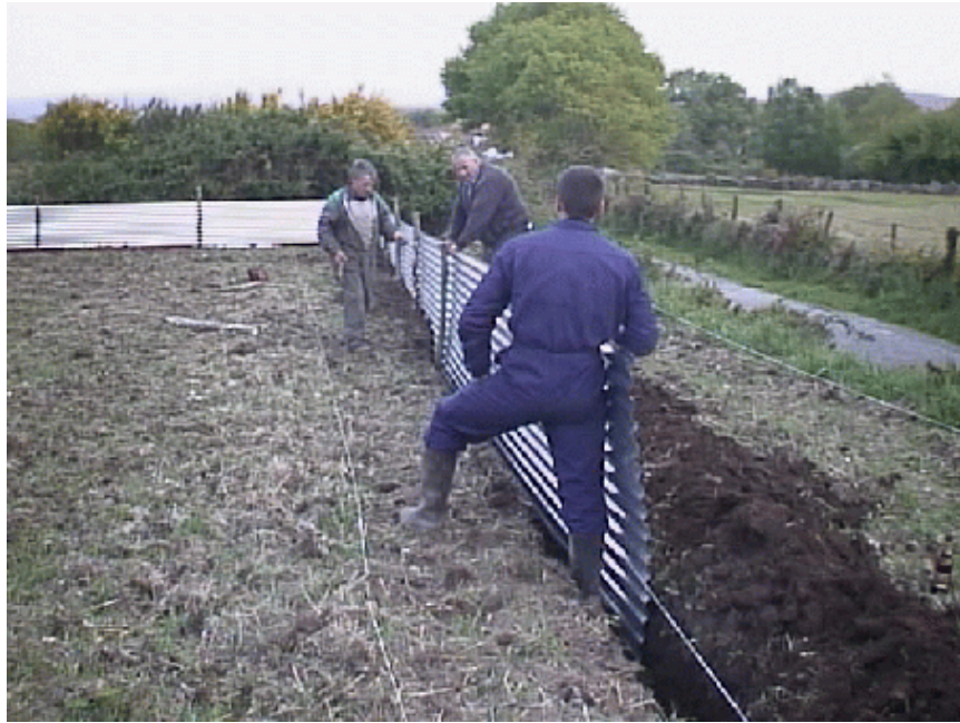
Foto 7: Colocando las planchas galvanizadas
