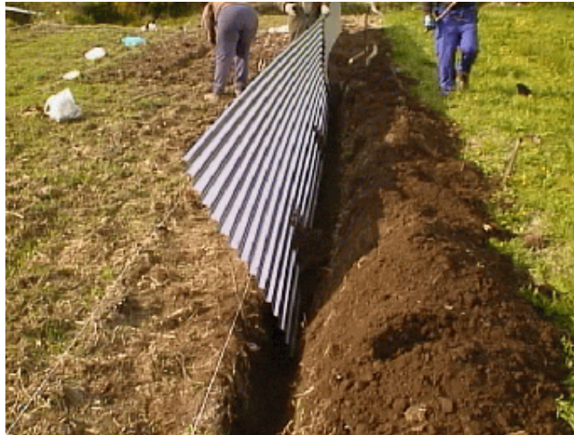
Foto 5: Forma de montar las placas del perímetro
