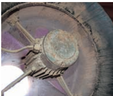
Chimenea de extracción de aire en su interior estará colocado el ventilador
