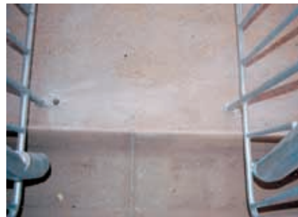
Comedor corrido en una nave de gestación a ras de suelo.
