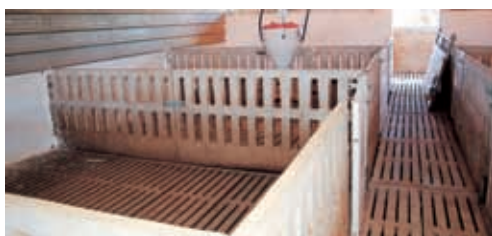
Se coloca suelo enrejillado parcial o total.
