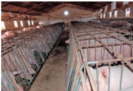
Jaulas de la zona de cubrición.
