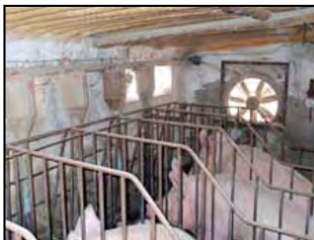
Figura 2.- Material aislante en la cubierta.
