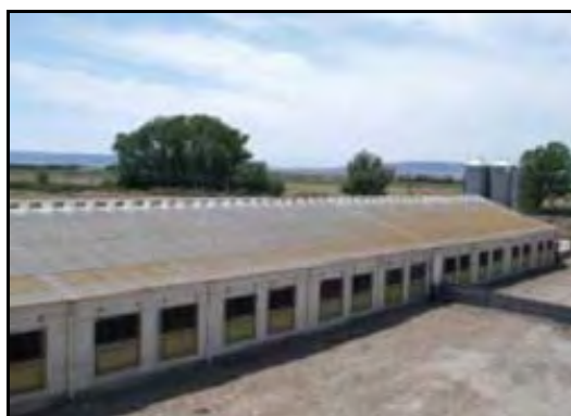
Figura 3.-Ventilación natural vertical.
