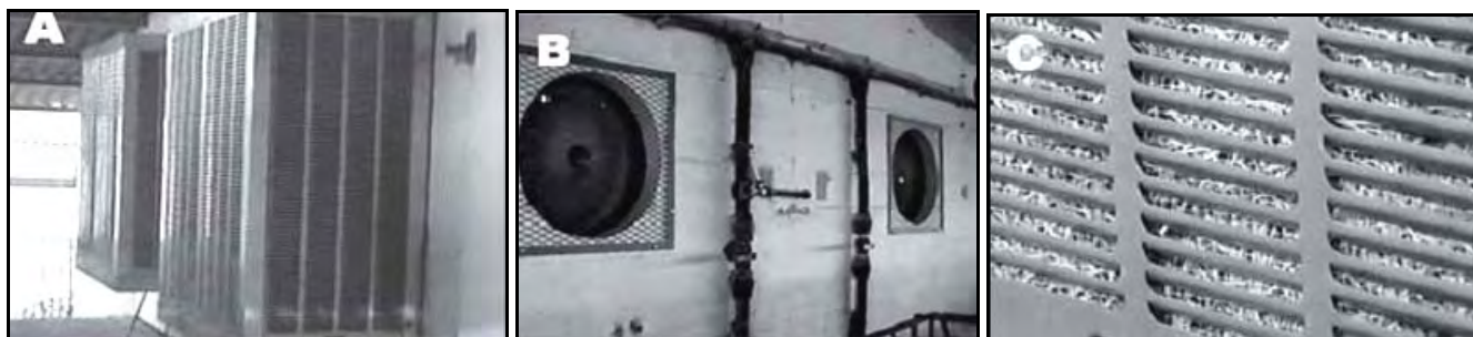
Figura 5.- Cooling por fuera (A) y por dentro (B) de la nave y detalle de su material de fabricación (C).
