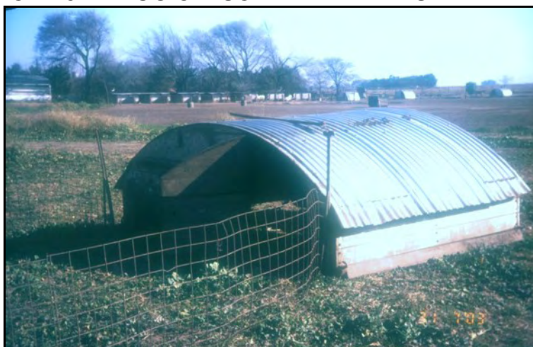
FOTO N° 5. REFUGIO PISO DE TIERRA. VISTA ANTERIOR
