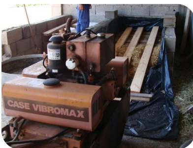
5. Proceso de prensado de silo con rodillo compresor
