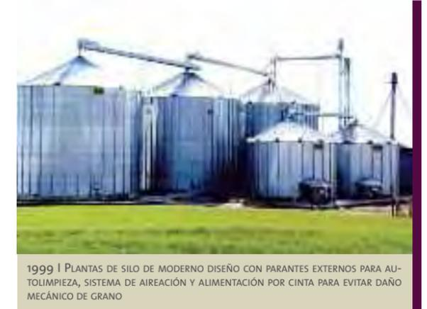
1999 | PLANTAS DE SILO DE MODERNO DISEÑO CON PARANTES EXTERNOS PARA AUTOLIMPIEZA, SISTEMA DE AIREACIÓN Y ALIMENTACIÓN POR CINTA PARA EVITAR DAÑO MECÁNICO DE GRANO
