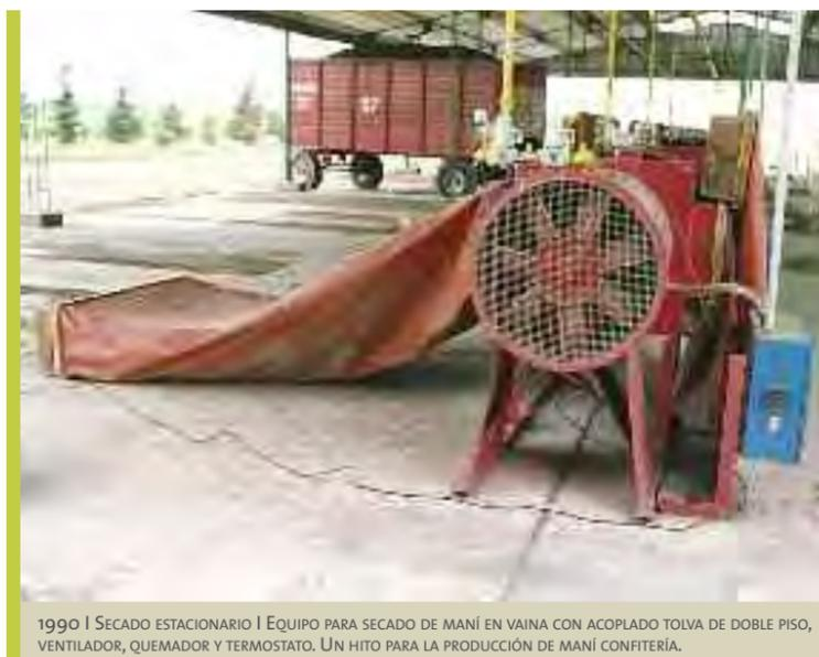
1990 | SECADO ESTACIONARIO | EQUIPO PARA SECADO DE MANÍ EN VAINA CON ACOPLADO TOLVA DE DOBLE PISO, VENTILADOR, QUEMADOR Y TERMOSTATO. UN HITO PARA LA PRODUCCIÓN DE MANÍ CONFITERÍA.
