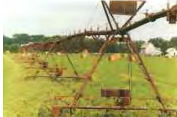
1968 | REINKE INVENTÓ EL PRIMER PIVOT CENTRAL CON AVANCE ELÉCTRICO | EN ARGENTINA LOS PIVOT ELÉCTRICOS Y OLEOHIDRÁULICOS SE INTRODUJERON EN 1980 | 4 A 5 KG/CM<sup>2</sup> DE PRESIÓN
