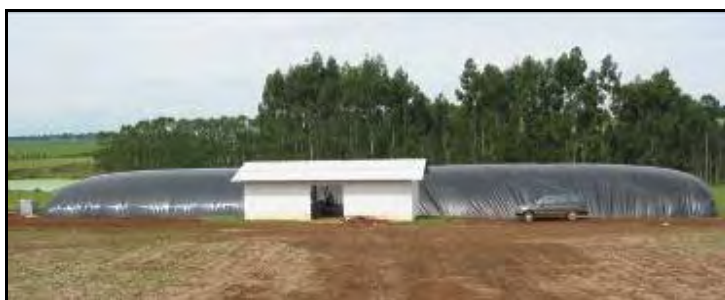
Figura 11.- Vista externa del digestor en pleno funcionamiento con su capa plástica protectora externa inflada por el biogás. En primer plano la sala donde se ubican los compresores, reguladores de presión, bombas inyectoras de oxígeno, filtros y motores eléctricos.
