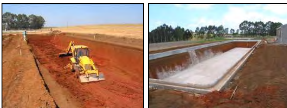
Figura 5.- Construcción del digestor principal para almacenamiento de los residuos primarios del establecimiento y generación y captación del gas metano. Se observa el cordón en forma de "U" y la capa de arena sobre la cual se coloca la lona plástica para impermeabilizar la fosa.
