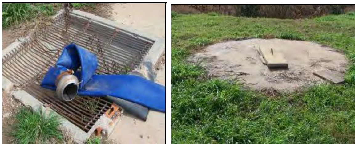
Figura 21: Una vez cargado el equipo con biofertilizante la manguera se coloca sobre la cámara que muestra la foto de la izquierda. Esta cámara esta conectada al depósito (de hormigón armado) que esta a unos 10 metros de distancia. En este depósito se almacena el biofertilizante que queda en la manguera luego de la carga. Cuando este depósito se llena, con una bomba conectada a la toma de fuerza del tractor se carga la estercolera. En Granja "Marujo" se trata por todos los medios evitar la contaminación del ambiente con los efluentes.
