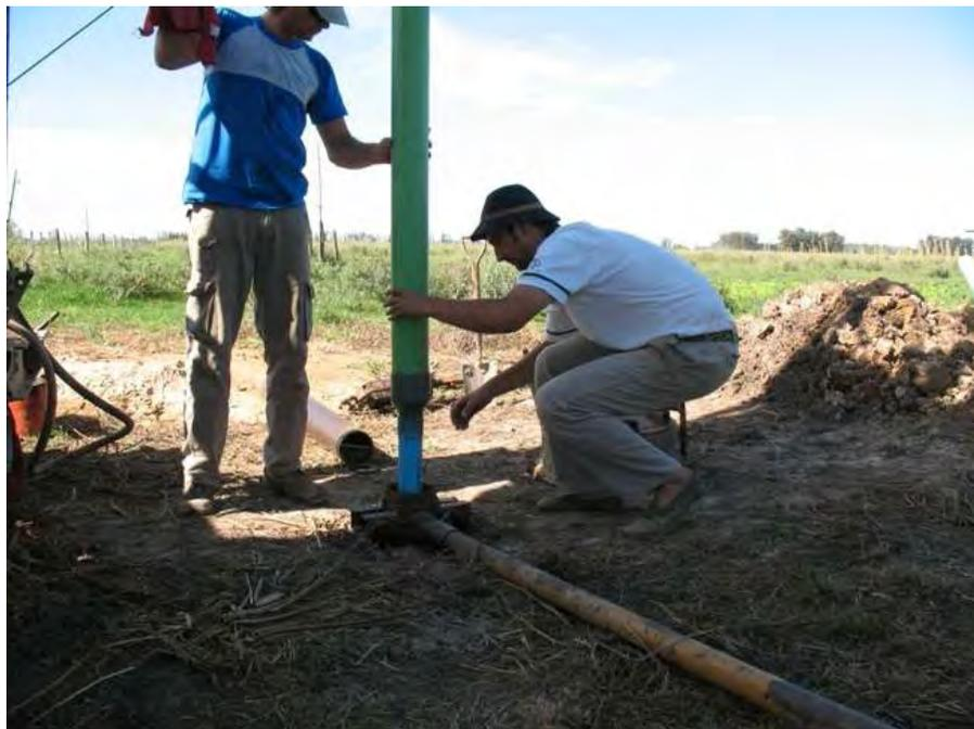
Comienzo de la colocación del filtro en la perforación. Se observa el buje reducción de 115 mm a 75 mm que permite la unión del filtro con el encamisado superior.
