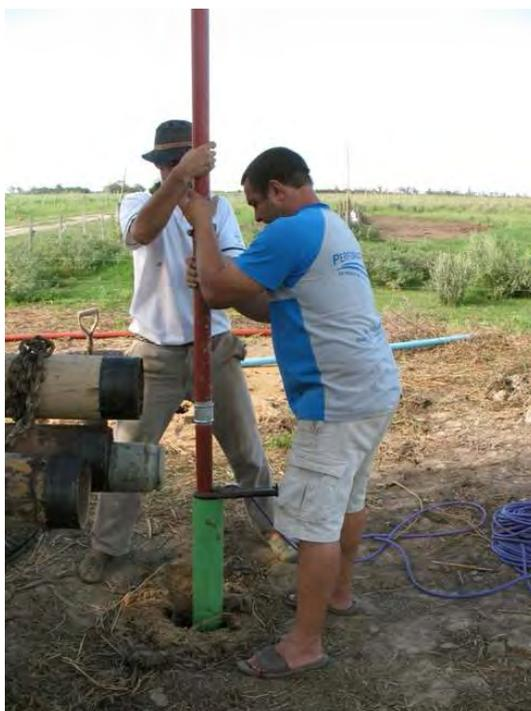
**Ensamblaje de los caños de PP de 2" y cable eléctrico de la electrobomba.**
