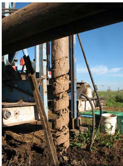
**Material extraído a los 7,0 m de profundidad (arcilla) con el sistema rotativo**
