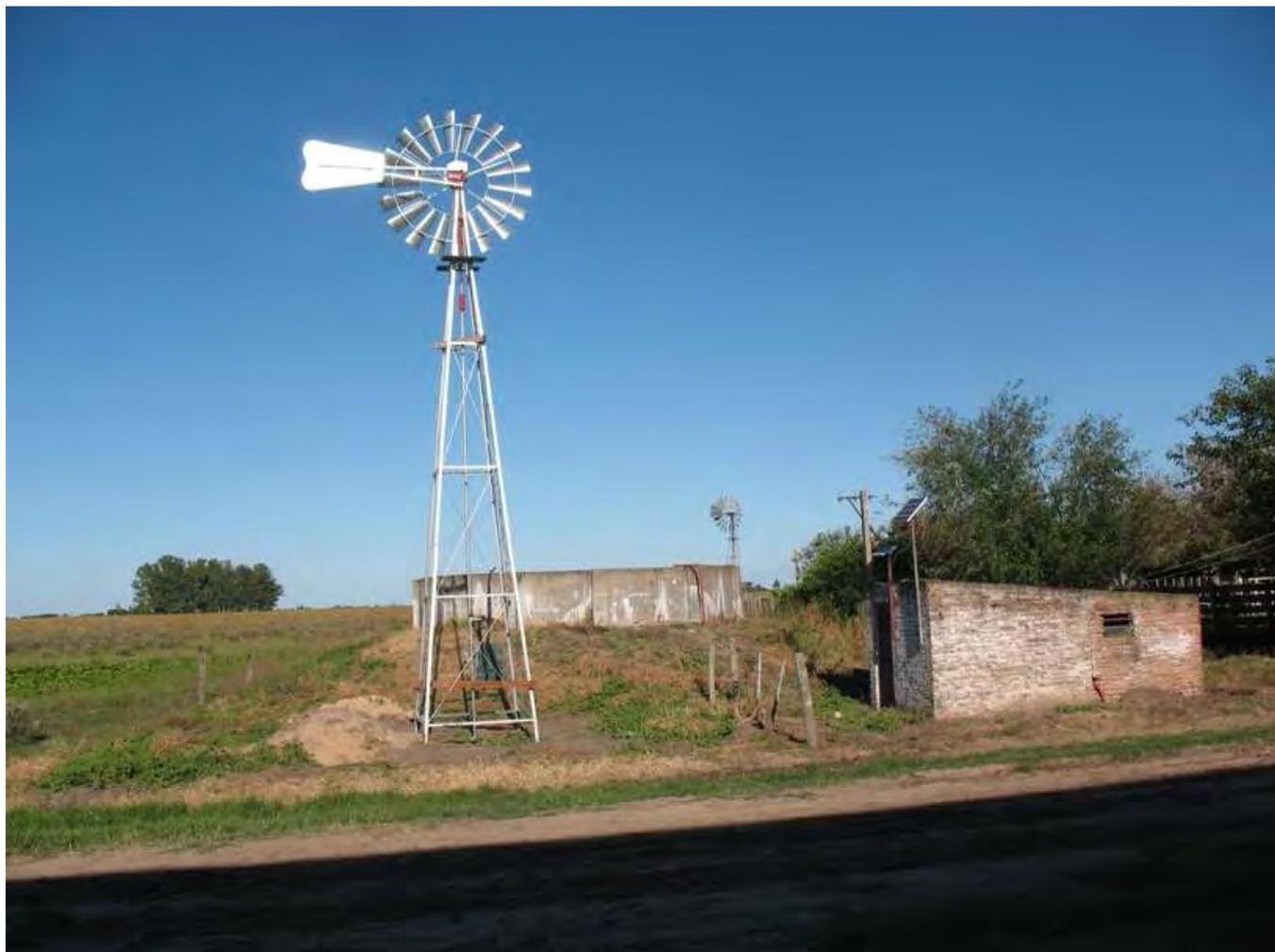
**Disposición final del molino implementado con el complemento de una electrobomba sumergible en el Sector de Ganadería de la EEA Reconquista para investigación.**
