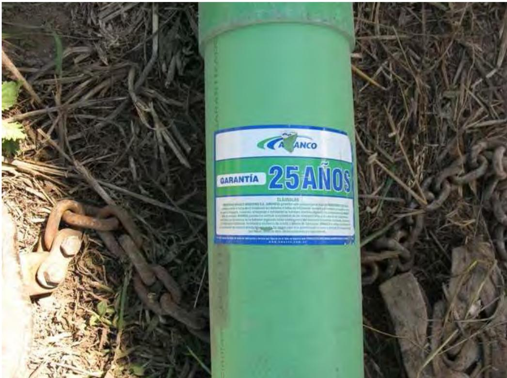
**Cañería Marca AMANCO utilizada para el entubamiento final de la perforación.**
