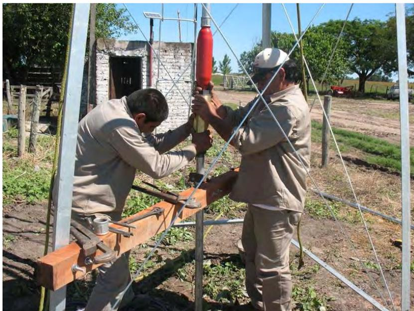
**Instalación de la bomba del molino, después de haber bajado la electrobomba sumergible**
