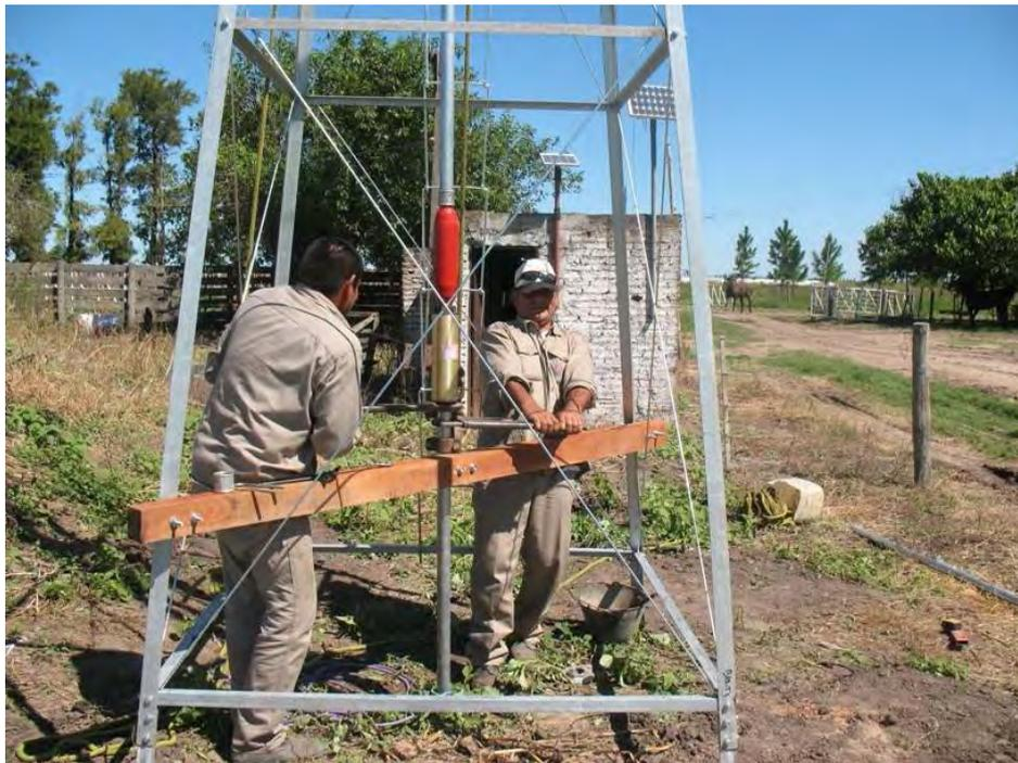
**Momento de la instalación de la cañería que sostiene a la electrobomba sumergible con la bomba del molino**
