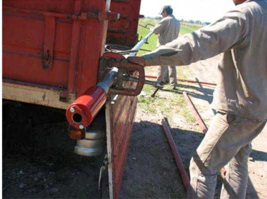
**Colocación de un elevador de agua en la parte superior de la cañería del molino**
