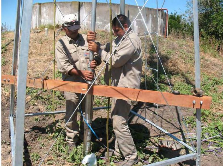
**Instalación de la electrobomba sumergible con cañería de HG° de 1 ½ “para unirla a la bomba del molino**
