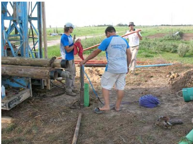
**Electrobomba sumergible al momento de colocarse en la perforación**
