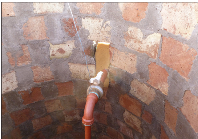
Figura 10. Llave esférica para regular la extracción de agua del jagüel.
