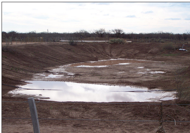
Figura 6. Construcción de tajamar en un relieve plano-cóncavo con afluencia natural de agua. Taludes con una pendiente 3:1.
