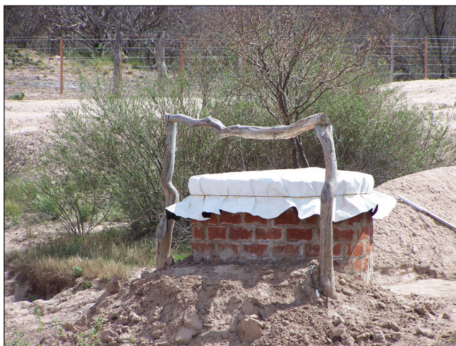
Figura 5. Jagüel protegido del ingreso de material contaminante.
