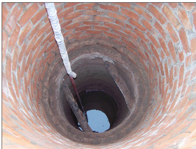
Figura 4. Pozo calzado a partir de una capa dura del subsuelo).
