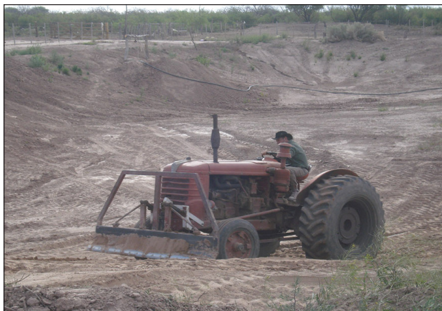
Figura 17. Labores de mantenimiento del tajamar con tractor equipado con pala frontal.
