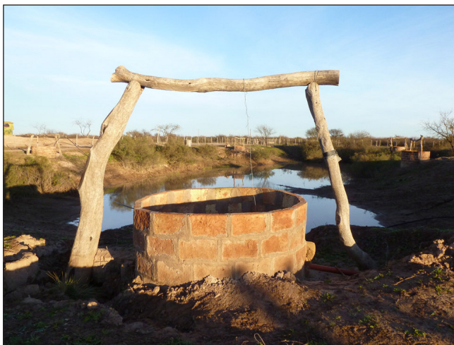
Figura 8. Vista del tajamar, jagüeles calzados sobre el talud y alambrado perimetral.
