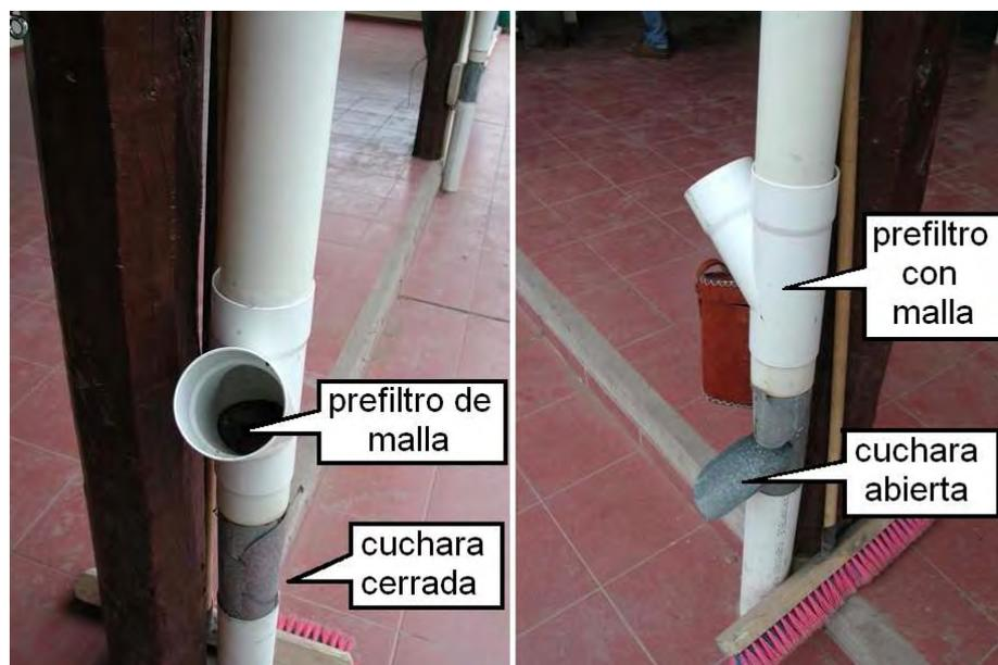
**Figura 4:** Sistema de prefiltrado y cuchara para eliminar el material vegetal, insectos y sedimentos proveniente de los techos.
