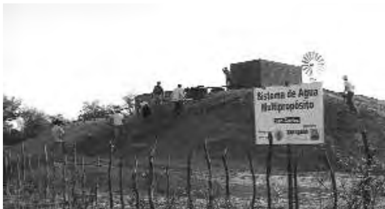
Sistema de agua de San Carlos
