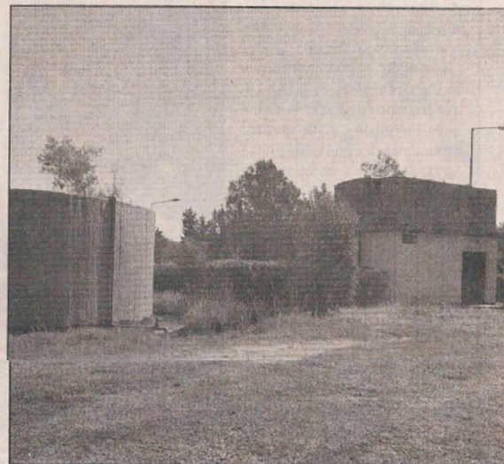
Planta: vista de la actual planta de agua de la localidad de Chaján.
