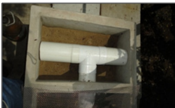
Figura 10: Filtro cargando con arena.
