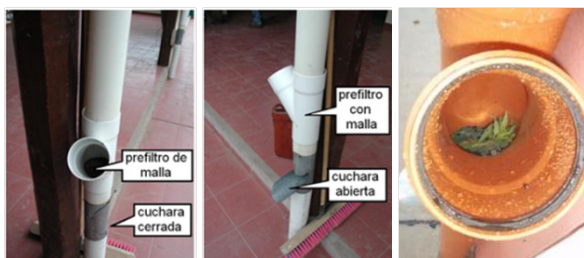
Figura 4 - Sistema de prefiltrado y cuchara para eliminar materia vegetal, insectos y sedimentos gruesos.
