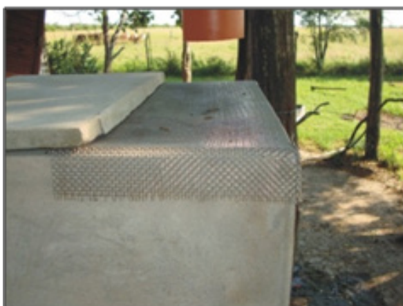
Figura 11: Malla que actúa como sistema de prefiltrado.
