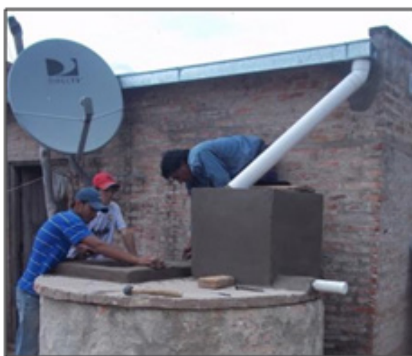
Figura 12: Filtro compacto sobre la tapa del aljibe.
