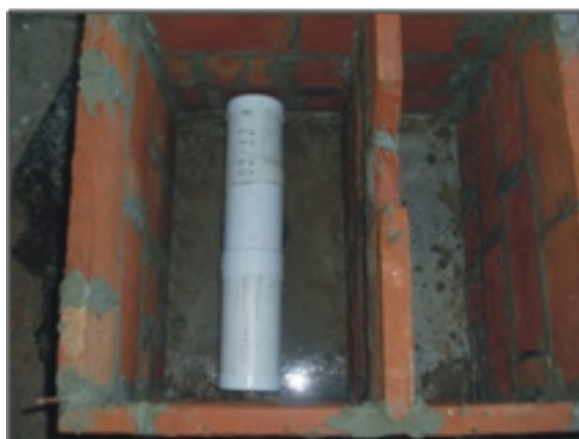
Figura 8: Dren inferior que comunica el filtro con el aljibe.
