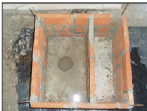
Figura 7: Losa de Hº y paredes de mampostería.
