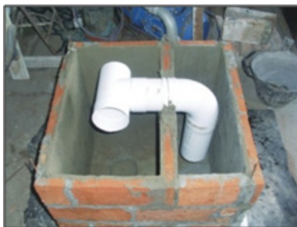
Figura 9: Cañería que une el sector de decantación con el filtro de arena.
