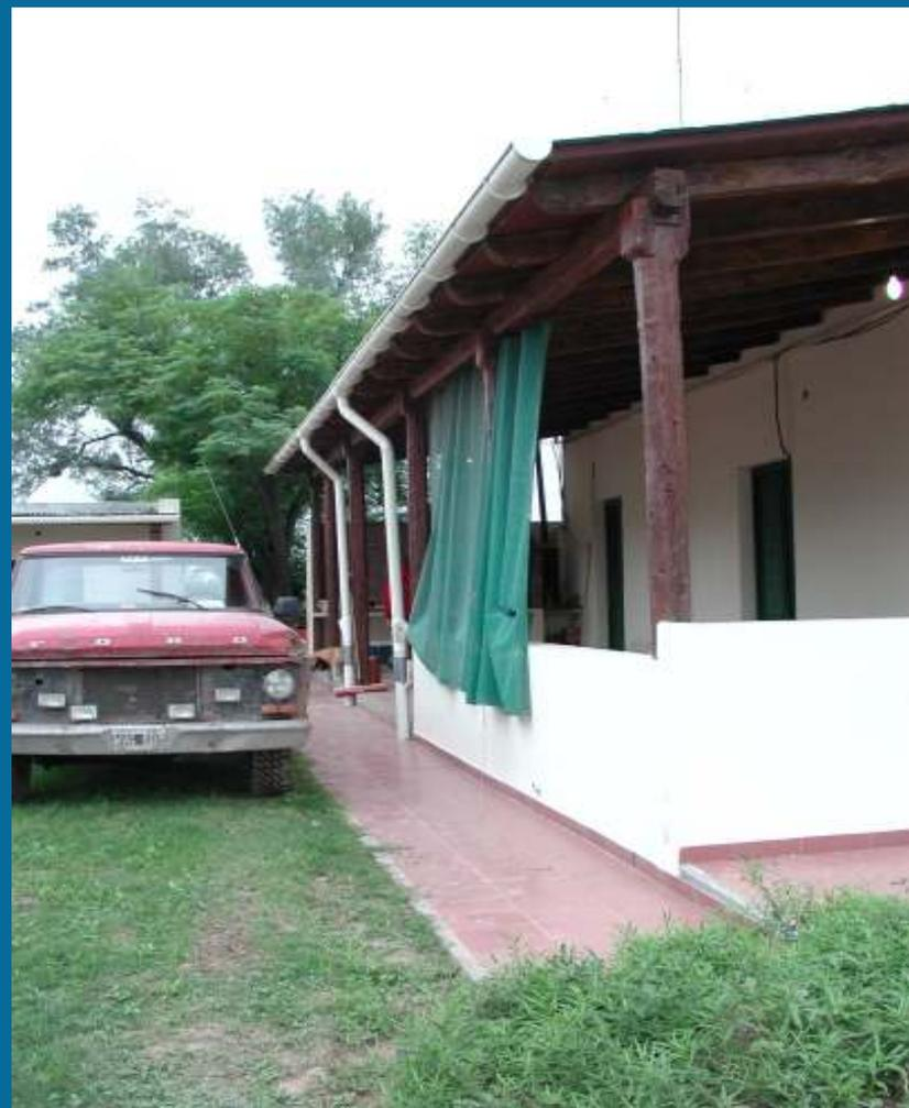
**Canaletas de tamaño adecuado, con suficientes cañerías de bajada y sistemas de prefiltrado:**
