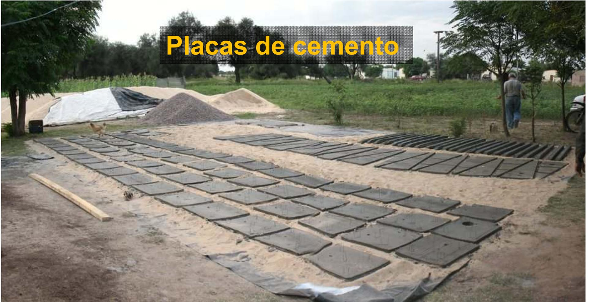
Ver Informe Técnico del paso a paso de un aljibe con placas de cemento mejorado del original: <http://inta.gob.ar/documentos/capacitacion-en-la-construccion-de-cisternas-placas-con-sus-obras-accesorias/>
