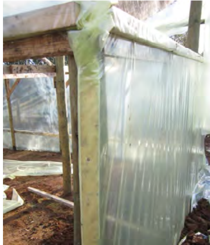
Figura 19. Sujeción del plástico en su parte lateral.
