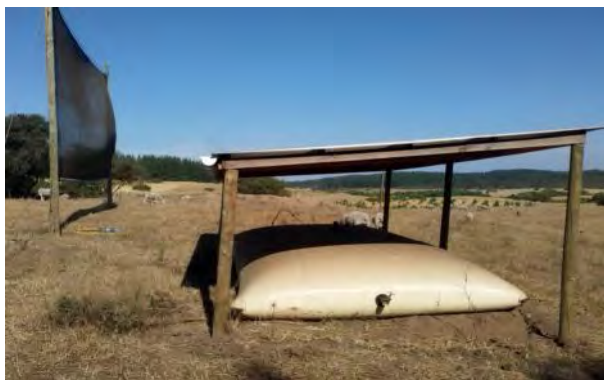
Figura 3. Cisterna flexible de 10.000 litros de capacidad, para la acumulación de aguas captadas por un sistema “Atrapanieblas”. Centro Experimental Hidango, INIA. Comuna de Litueche, Región de O’Higgins.
