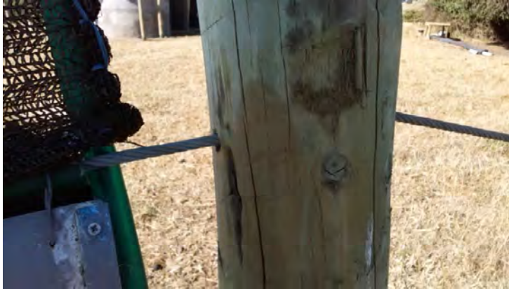
Figura 15. Alambre acerado que cruza uno de los postes de la estructura "Atrapanieblas". La prolongación hacia la izquierda sostiene la malla Raschel, y la de la derecha va hacia un tensor construido en el terreno.
