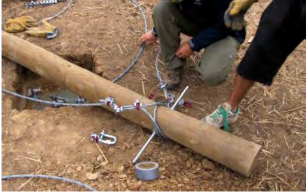
Figura 13. Labor de amarra a la varilla de anclaje del alambre acerado, en la parte superior de cada poste de la estructura.
