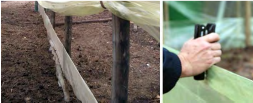
Figura 16. Instalación de bandas de proyección sobre alambre.
