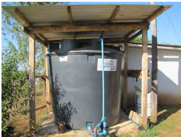
Figura 16. Sistemas de captación y acumulación de aguas lluvias utilizando techos de las casas y estanques acumuladores de 5.000 a 5.400 litros. Comuna de La Estrella, Región de O'Higgins.
