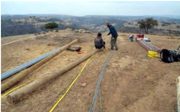
Figura 11. Perforación y preparación de los postes, y del corte del alambre acerado para la estructura "Atrapanieblas".
