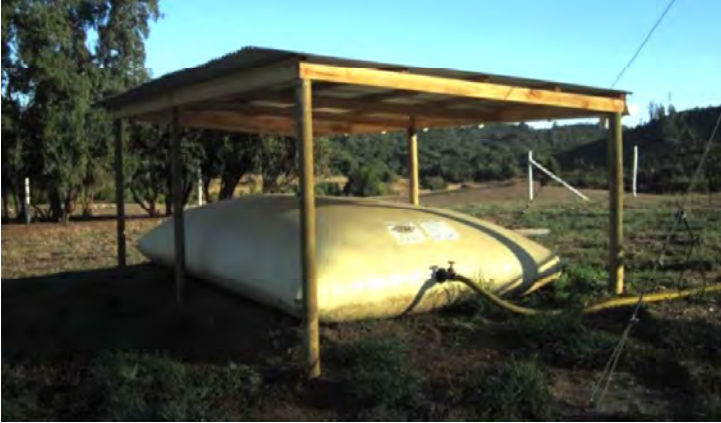
Figura 12. Cisterna flexible de 10.000 litros a máxima capacidad de acumulación de agua, techo de zinc y madera de protección. Litueche, Región de O'Higgins.
