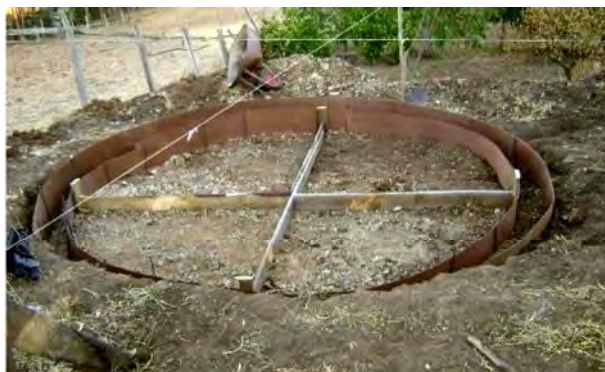
Figura 11. Excavación para la cimentación.
