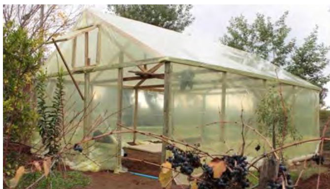
Figura 28. Invernadero con el plástico instalado.
