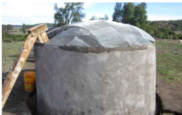
Figura 30. Cubierta de la cisterna, con fierro y malla en condiciones para ser revestida con la mezcla de cemento, arena, y agua.
