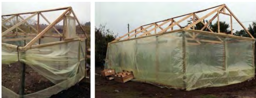
Figura 18. Fijación del plástico alrededor del invernadero.
