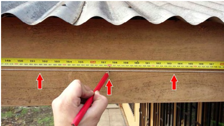
Figura 3. Marca para determinar la unión de canaletas y ubicación de ganchos cercanos a ella.
