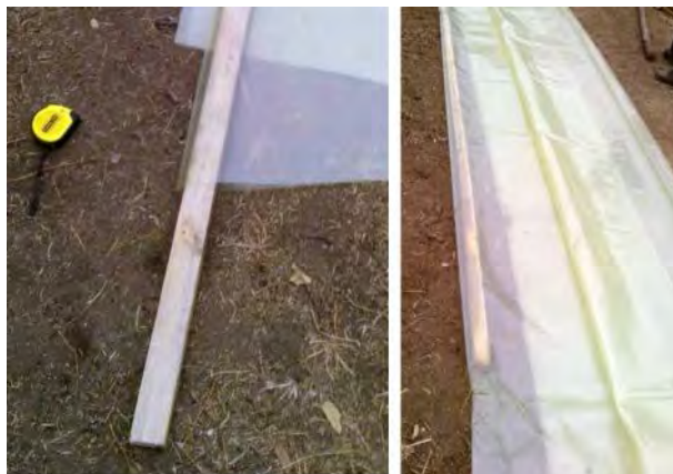
Figura 20. Preparación del polietileno para cubrir el techo.
