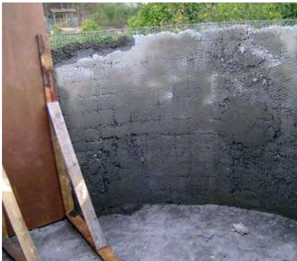
Figura 25. Mezcla aplicada cubriendo totalmente la malla.
