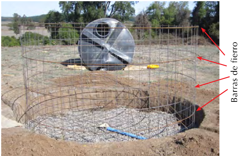
Figura 16. Formación del cilindro de la cisterna, utilizando una estructura con hierro estriado diámetro 8 mm.
