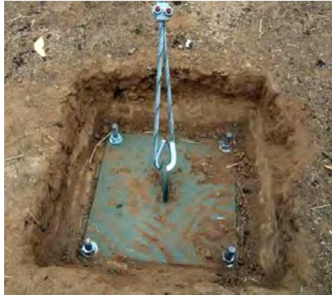
Figura 10. Anclaje metálico, apernado a la roca, utilizado para sostener la estructura "Atrapanieblas". La Aguada, Comuna de Navidad, Región de O'Higgins.
