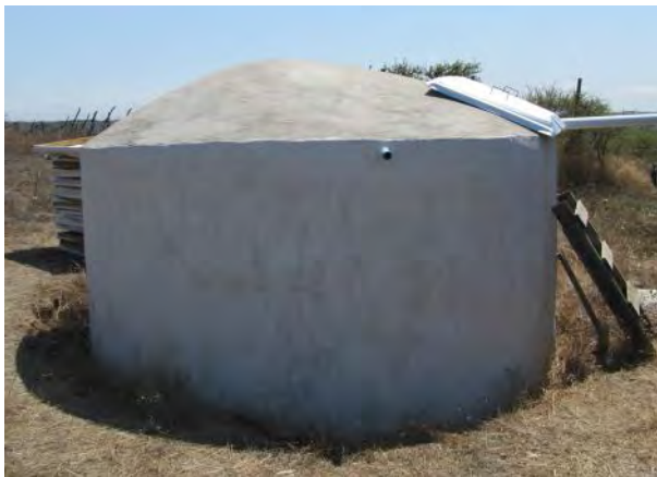
Figura 1. Cisterna de ferrocemento de 10.000 litros de capacidad.
