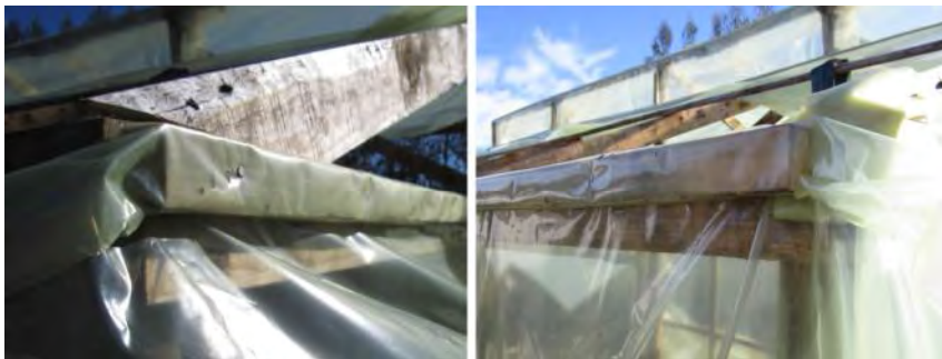
Figura 17. Sujeción del plástico en la parte superior del larguero.
