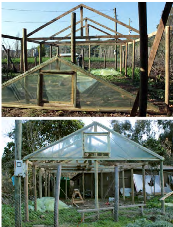
Figura 9. Detalle de la cercha frontal con la ventana de ventilación previamente instalada.
