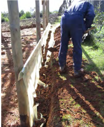
Figura 15. Instalación de bandas de protección sobre madera.
