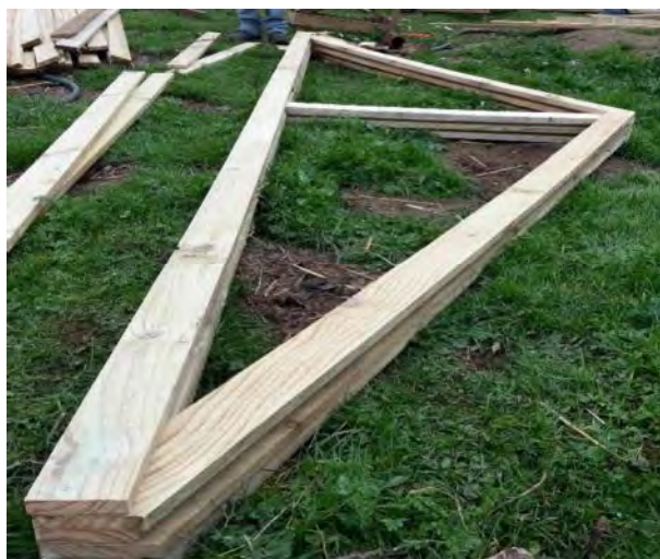
Figura 5. Construcción de cerchas centrales.
