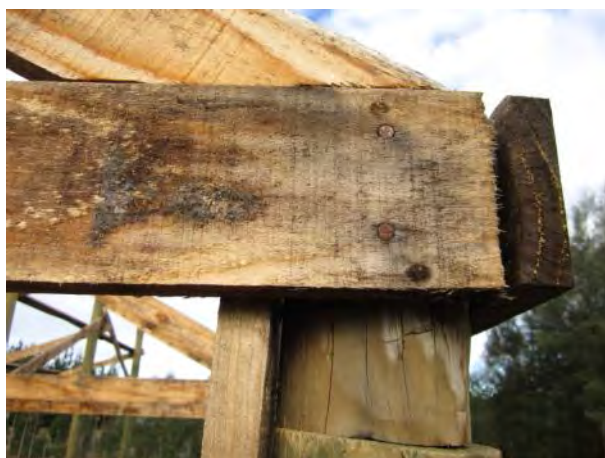
Figura 13. Terminación de los frentes del invernadero.
