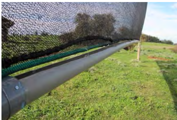
Figura 2. Canaleta instalada bajo la malla Raschel de un sistema “Atrapanieblas”, para la captación de agua de neblina o lluvia.
