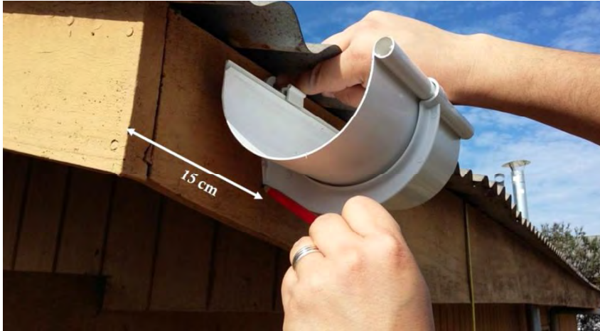
Figura 1. Ubicación del primer gancho de sujeción para dar inclinación a la canaleta.
