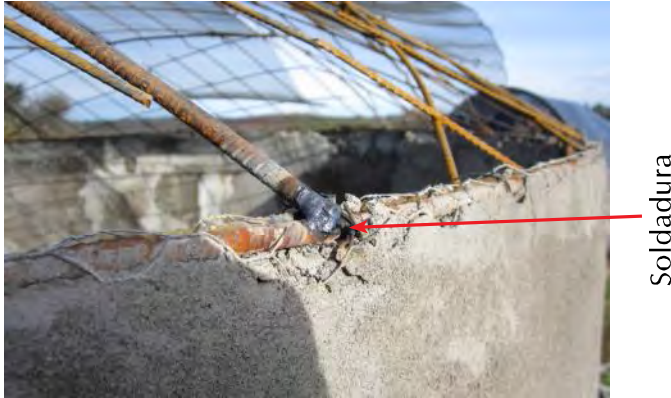
Figura 27. Detalle de la soldadura de los arcos para la cubierta.
