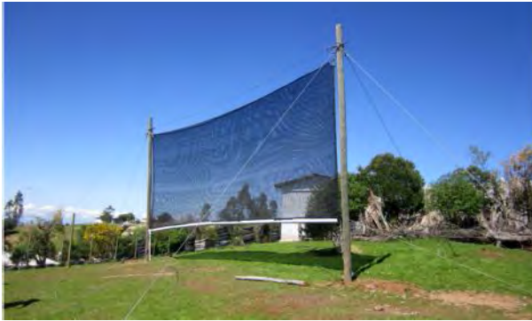
Figura 1. Estructura "Atrapanieblas" con malla Raschel de 40 m 2 de superficie, para la captación de nieblas y aguas lluvias instalada por INIA. La Aguada, Comuna de Navidad, Región de O'Higgins.
