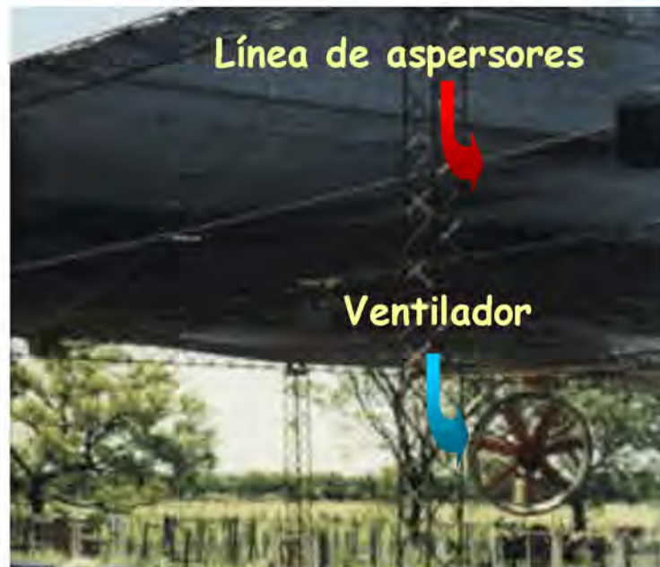
Foto 4. Detalle de ventilador y línea de aspersores en un sistema combinado de refrigeración en el corral de espera
