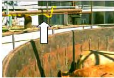
Cintas amarillas suspendidos
