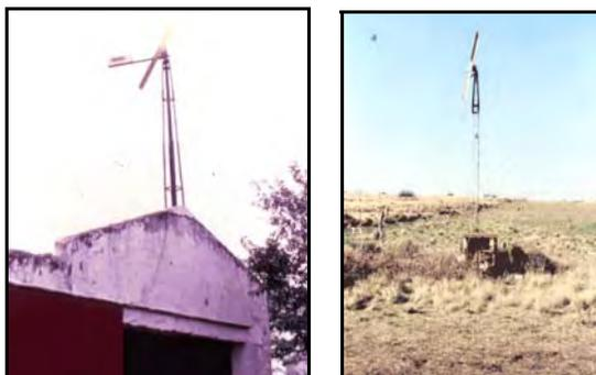
a)-Central eléctrica: aerocargador sobre un galpón. b)-Aéreocargador para eléctrico en plena sierra del Comechingones; equipo protegido por una heladera en desuso.
