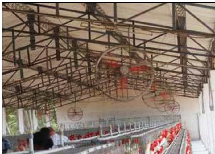
Figura 3. Los ventiladores y nebulizadores aumentan la velocidad del aire dentro del galpón creando un efecto de enfriamiento.
