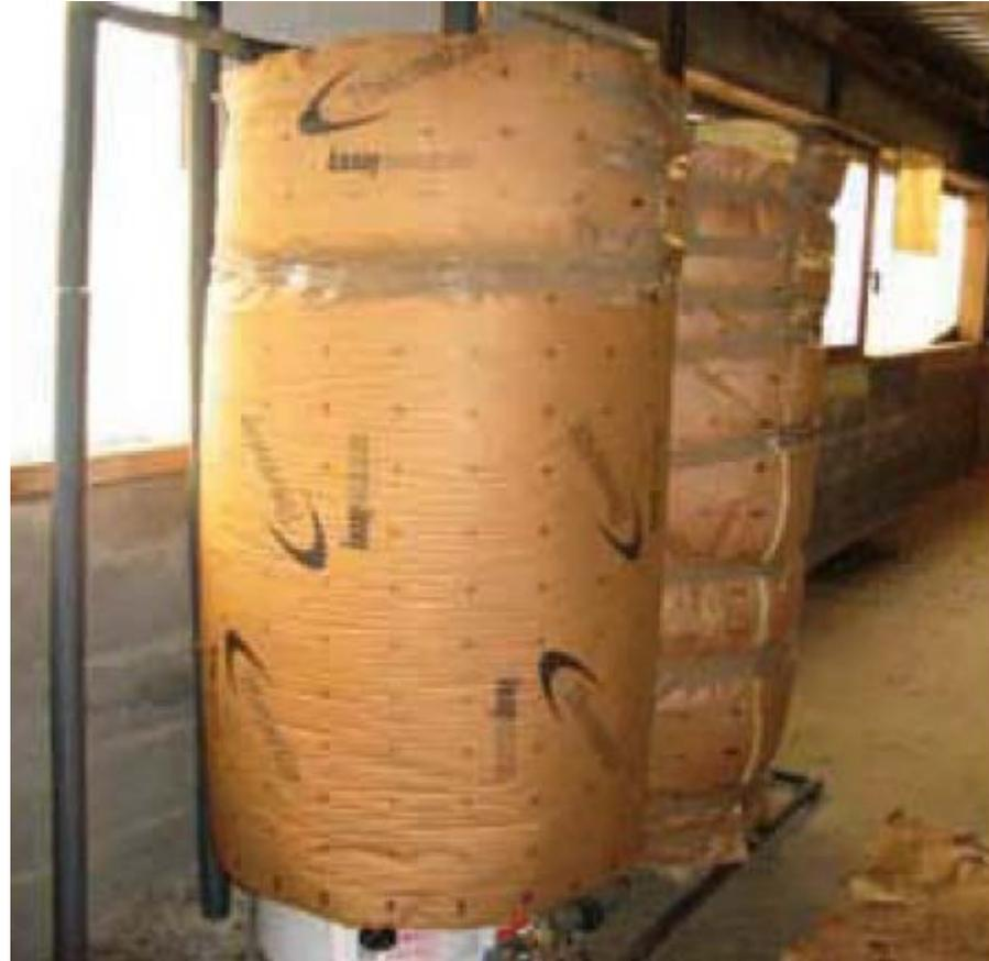
Aislación térmica = - **5-15 % consumo energético calentamiento agua para lavado**
