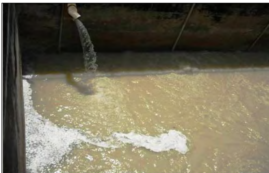
Foto 4; Tanque de Ecualización Planta de Tratamiento Productos Lácteos Flor de Aragua
