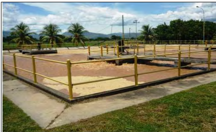
Foto 5; Reactor nº 1, Tratamiento Biológico lodos activados. Productos Lácteos Flor de Aragua
