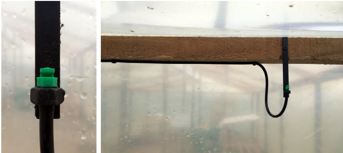
Figura 9. Izquierda: Sujeción de aspersor en tuerca tamaño 5/16"; Derecha: Vista de aspersor microjet 180° conectado a microtubo de 4 mm.
