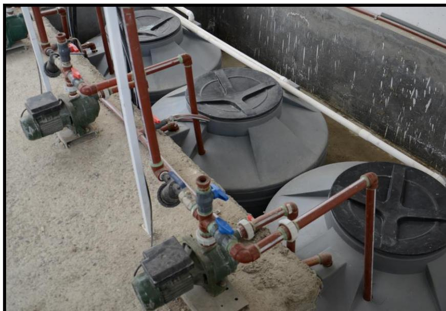
**Figura N°3.** Bomba utilizada en el sistema de bombeo.
