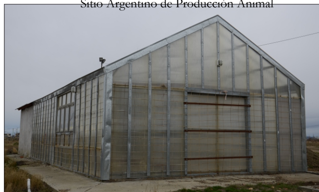
Invernadero hidropónico UNPA UARG
