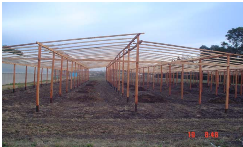
Foto 6: Invernadero tipo capilla con abertura cenital
