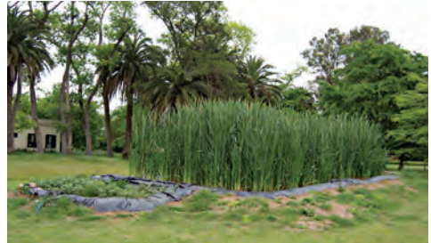
Humedal construido para tratamiento de efluentes.
