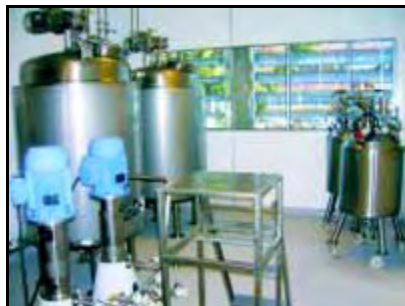
Foto 8. Sala de Formulación y Emulsiones.
