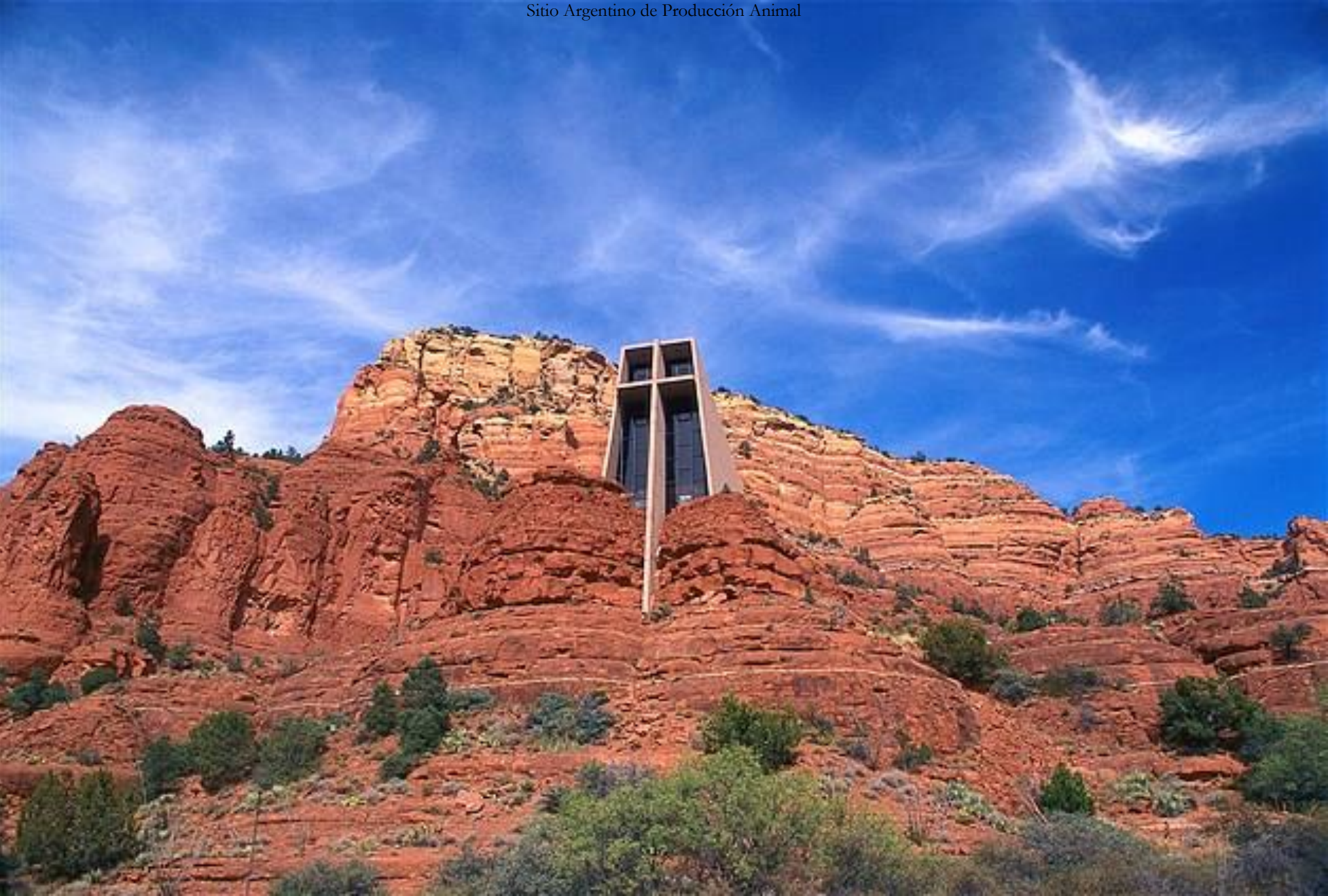
Capilla de la Santa Cruz, un templo católico romano en Sedona, Arizona (EE UU).
